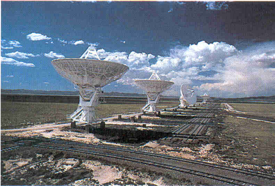
Algunos de los radiotelescopios del Dispositivo de Muy Gran Amplitud en Socorro, Nuevo Méjico, manejado por el Observatorio Nacional de Radioastronomía. Los telescopios se desplazan sobre vías de tren; su separación determina la resolución de la imagen de radio resultante. (Fotografía, Bill Ray.)
